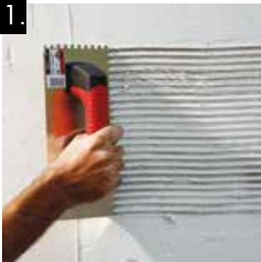
Extender el adhesivo con una llana dentada de 6mm de manera homogénea.
