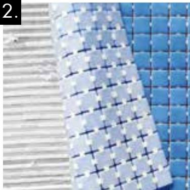
Colocar los paneles con el sistema de puntos **JointPoint®** y aplicarlos sobre la superficie.
