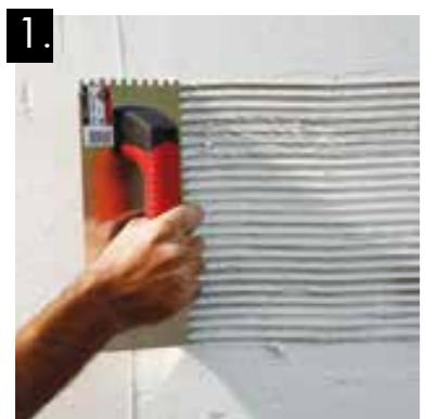
Extender el adhesivo con una llana dentada de 6mm de manera homogénea.
